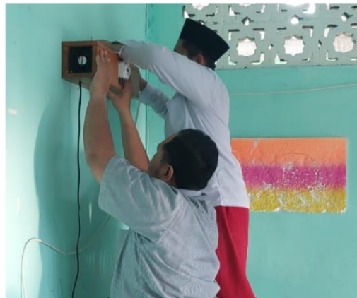
Gambar 2. Proses Pemasangan Alat Netralisator Udara
