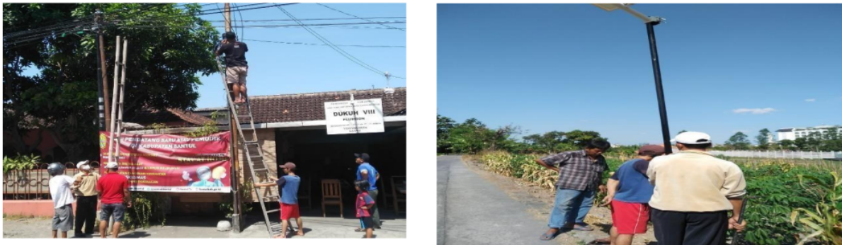
Gambar .6 Pemberdayaan masyarakat pemasangan “Dampit Solar Energy” Tenaga Surya sebagai penerangan Jalan
